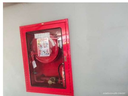
รูปที่ 22 เก็บสายฉีดน้ำดับเพลิงพร้อมอุปกรณ์
