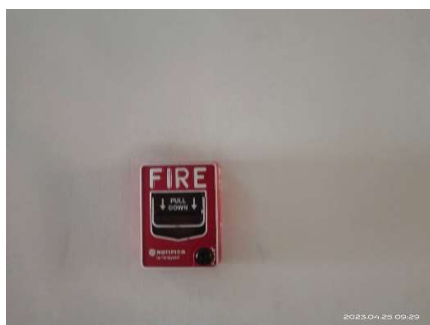
รูปที่ 23 อุปกรณ์แจ้งเหตุเพลิงไหม้แบบใช้มือ
