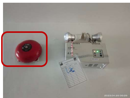
รูปที่ 24 อุปกรณ์แจ้งสัญญาณเตือนเพลิงไหม้
