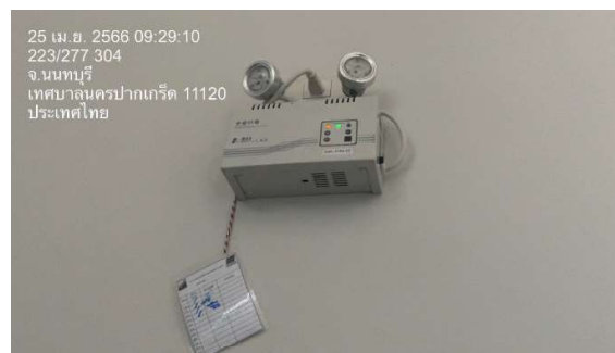
รูปที่ 28 ไฟส่องสว่างฉุกเฉิน
